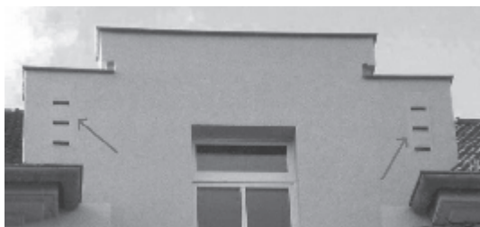
Obr. 23. Búdky inštalované hlbšie do zatepľovacej vrstvy, viditeľné sú len vletové otvory, foto: IFT
