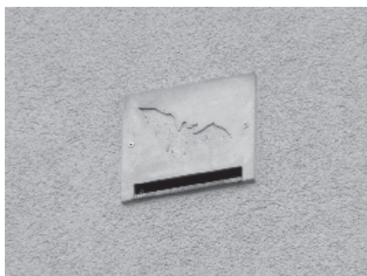
Obr. 17. Inštalovaná drevobetónová búdka do zateplenia, foto: IFT
