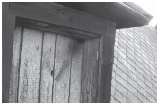
Obr. 8. Vyšmýkané a mierne znečistené miesto poukazuje na otvor, kade netopiere vliezajú do podkrovia, foto: M. Ceľuch
