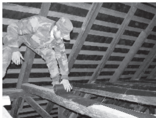
Obr. 28. Lepenkové pásy uchytené viazacím drôtom chránia trámy pred trusom, foto: M. Celuch
