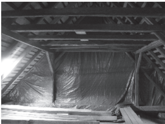
Obr. 29. Je možné aj oddelenie časti podkrovia pre netopiere, alebo ako dočasné opatrenie minimalizujúce vyrušovanie kolónie počas prác na podkroví, foto: M. Celuch
